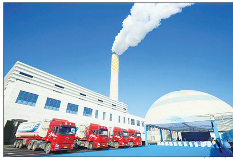
图为污泥耦合掺烧全量处置工程。 资料图片
