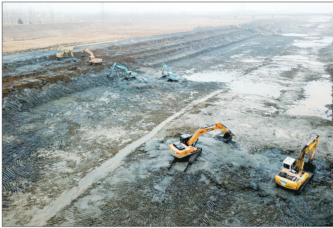
连日来,江苏省连云港市海州区水利部门组织220余台挖掘机,集中对鲁兰河(海州区段)三个标段进行清淤作业,计划2021年5月底完工,届时将有效提高河道及区域防洪排涝标准,保护沿线生态环境,促进地方经济发展。
