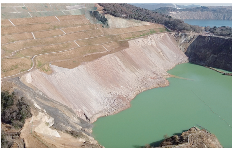
图为冬至前后航拍下的大王山丁山矿区。
