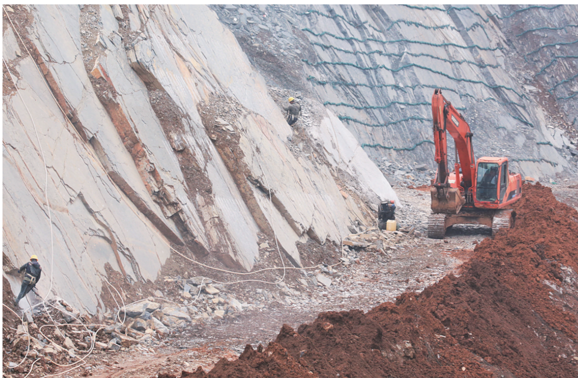
在安徽省铜陵市义安区天门镇董电舒山采石厂闭坑山地地质环境治理现场,工人们按计划有序对矿山进行修复。
