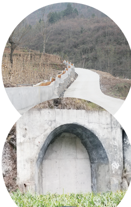
图为狮子岭收集渠道
