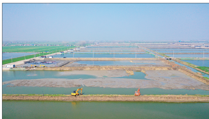
根据《江苏省水利厅关于淮安市白马湖退圩(围)还湖工程实施方案的批复》，需将位于江苏省淮安市洪泽区岔河丰产河入湖口北侧的二圩渔场地块划入白马湖保护范围，这一区域2308.5亩地块率先实现退圩还湖。
