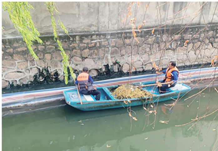
图为养护作业人员现场提取渗漏水样。 本报通讯员吴滨摄
