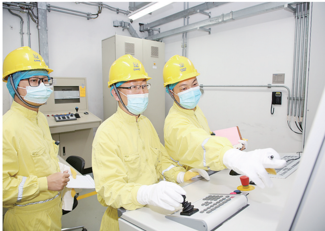
因为正在开展换料大修后临界前控制点现场检查。
