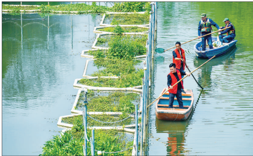
近年来，浙江省湖州市长兴县太湖街道开展“守护碧水蓝天行动”，在辖区河道、水源地设置2000多平方米生态浮床，种植具有净化水质能力的水生植物，以达到净化水质、优化水环境的目的。图为太湖街道白溪港内党员志愿者和村级河长正在进行水面漂浮物打捞，养护水生植物。 人民图片网供图
