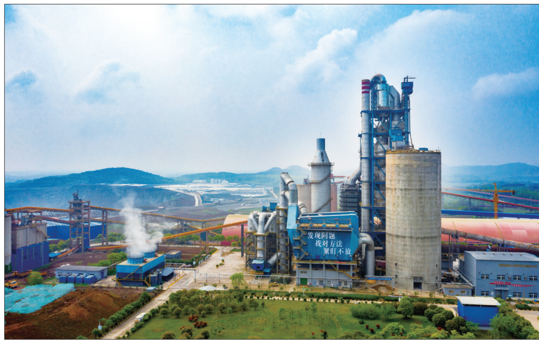
钢铁、建材(水泥)等行业今后将陆续纳入全国碳市场。图为某水泥窑协同处置项目。人民图片网供图
