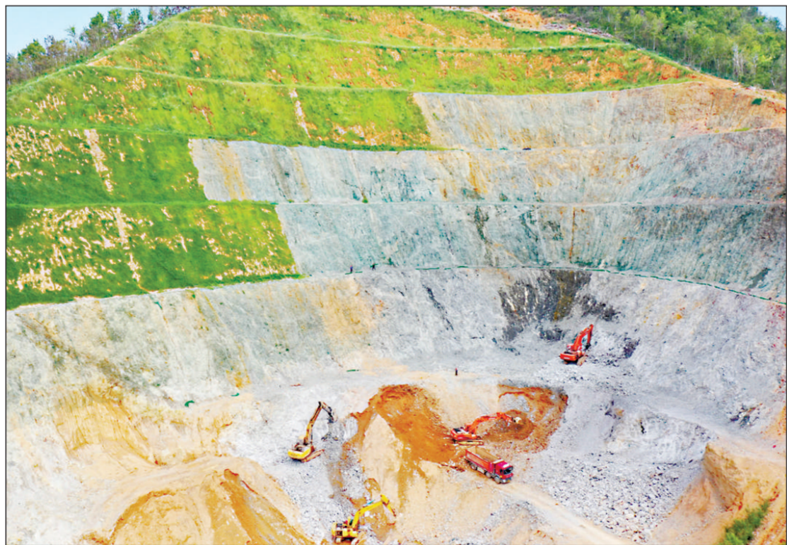
近年来,浙江省温岭市坚持“绿水青山就是金山银山”理念,加大城乡生态环境治理力度,大力开展废弃矿山和在生产矿山退矿复垦和生态修复,美化乡村环境,推进美丽乡村建设。图为温岭市坞根镇新方废弃矿山边坡锚固绿化修复工地,工人正在岩壁边铺设和加固钩花钢丝网,固化植绿。 人民图片网供图
