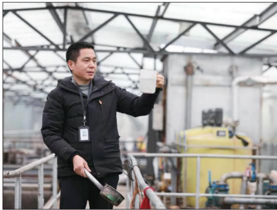
羊燕春对企业排入污水管网的废水进行取样检测。
