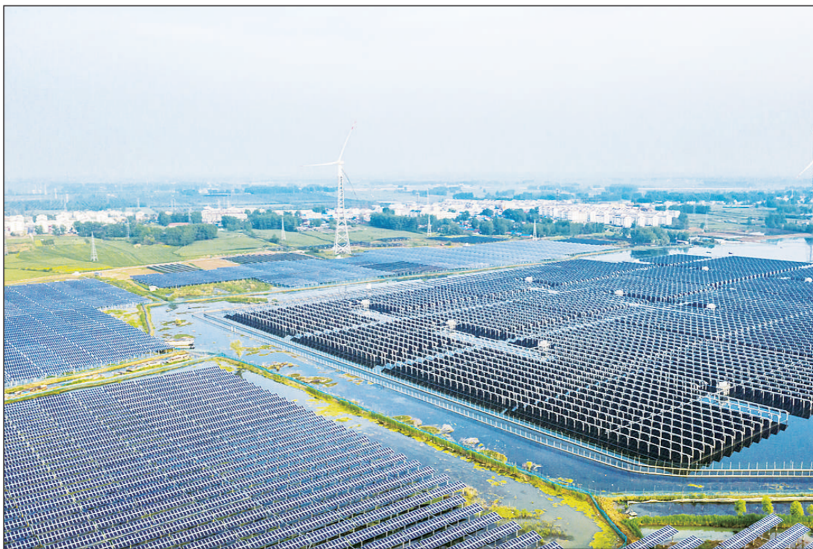
近年来,江苏省宿迁市泗洪县抢抓国家政策支持扶贫的大好机遇,充分发挥地方资源优势,大力发展绿色新能源产业,并使之成为乡村振兴的重要引擎。2018年成功引进光伏和风电项目以来,4年累计发电29.85亿千瓦时,其中光伏发电19.75亿千瓦时,风力发电10.10亿千瓦时,同时实施渔光互补、文旅融合,实现了经济、生态和社会效益的有机统一。
