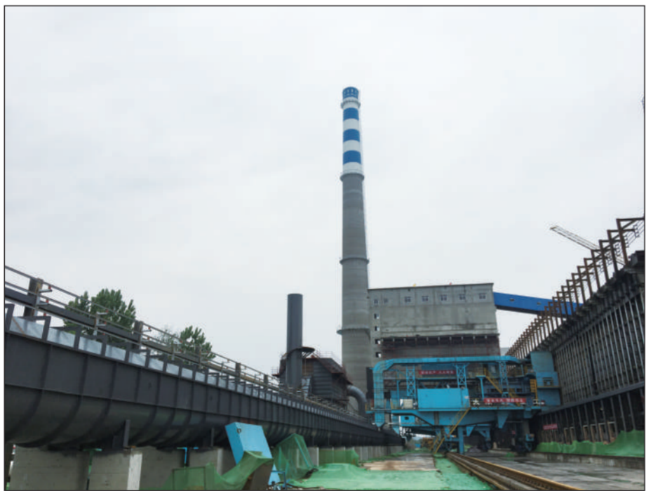
中央生态环保督察组成员赴现场勘察焦炉建设进度。中央生态环保督察组供图
