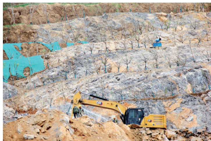
在安徽省淮北市烈山区泉山废弃宕口生态修复治理区,施工单位正在泉山边坡、陡崖上进行削坡、喷淋、雾炮降尘、复绿、喷播、回填压脚、场地平整、开挖种植槽等生态修复治理工程作业。
