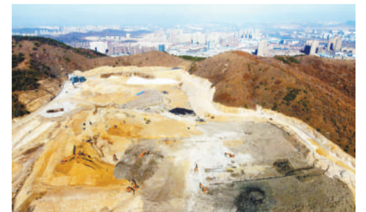
鞍山羊耳峪生活垃圾填埋场
