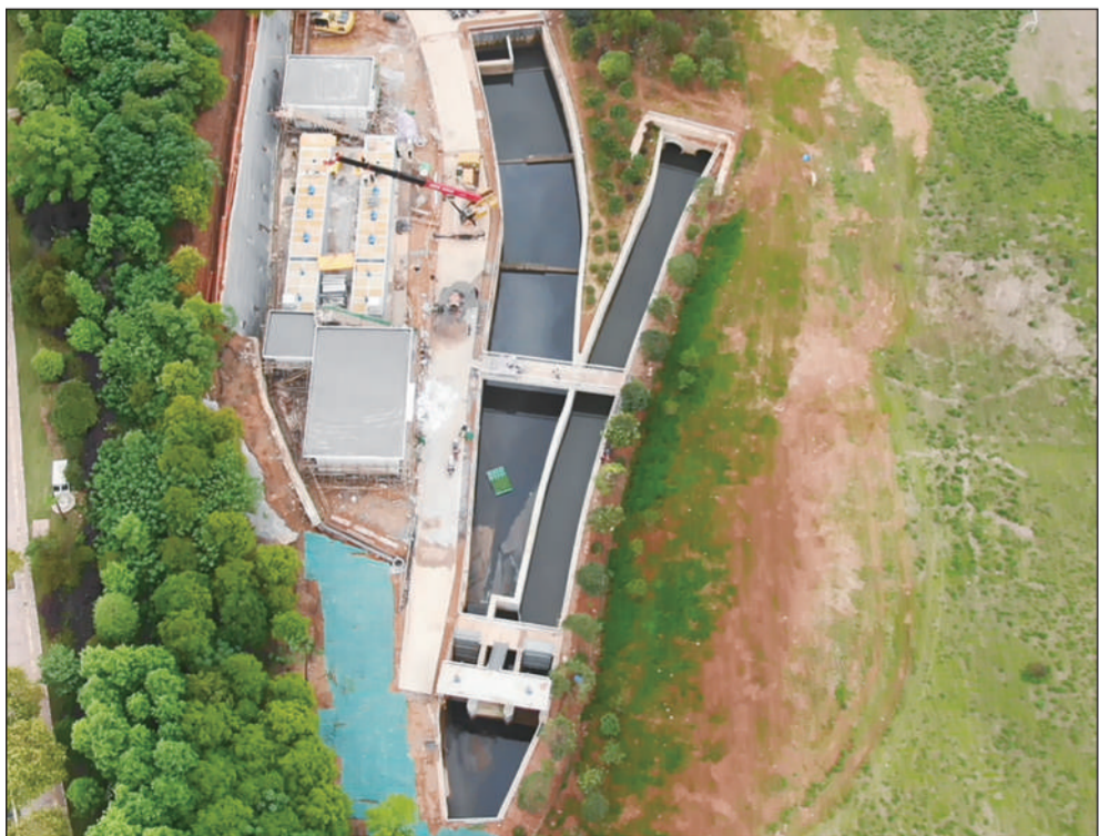
花南泵站调节池有大量生活污水混入。
