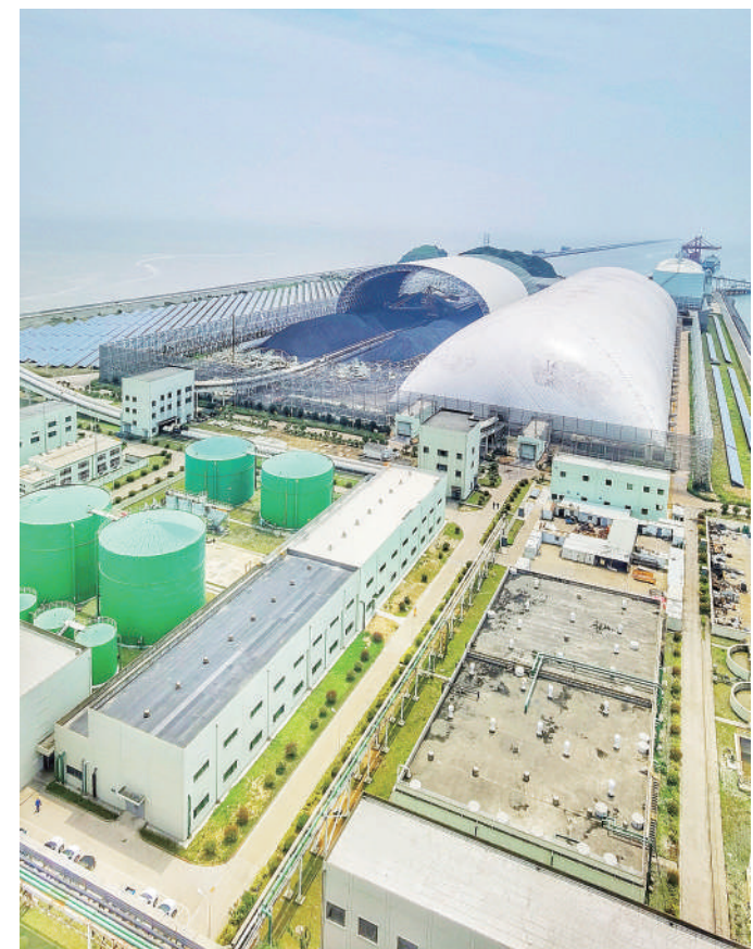
华润电力温州电厂近日煤场吹膜一次成功,成为国内已建成设计风压最大、华润电力首家投产的气膜煤场。张倩摄
