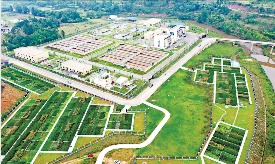
近年来,四川省眉山市仁寿县在实现污水处理全覆盖的同时,在每家污水处理厂(站)配套建设人工生态湿地。通过种植风车草、美人蕉、香蒲等水生植物,不但改变了环境,还使污水变成了清水,直接用于农业生产灌溉。
