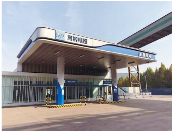
2020年8月28日,河钢集团邯鄹70MPa和35MPa双压力固定式加氢站建成投产,是国内钢铁企业率先建设的固定式加氢站。资料图片
