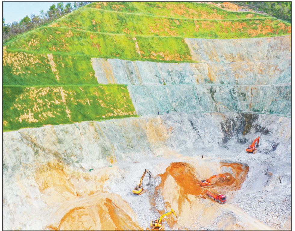
近年来,浙江省温岭市坚持“绿水青山就是金山银山”理念,加大城乡生态环境治理力度,大力开展废弃矿山和在生产矿山退矿复垦和生态修复,通过台阶围堰绿化、陡坡植生槽绿化等生态整治措施修复废弃矿山,美化乡村环境。图为温岭市坞根镇新方废弃矿山正在进行边坡锚固绿化生态修复。 人民图片网供图
