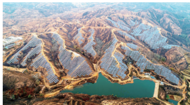
三峡能源“河北平山光伏电站”项目
