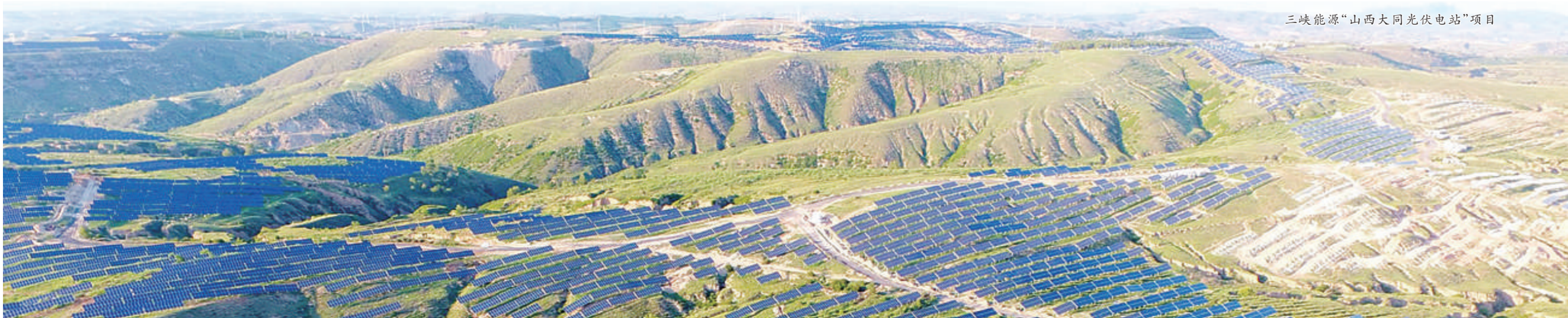
三峡能源“山西大同光伏电站”项目
