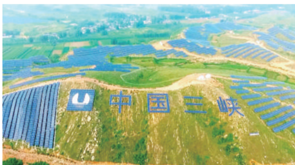
三峡能源“河北曲阳光伏电站”项目
