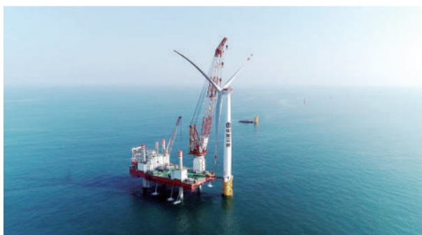
三峡能源“辽宁庄河海上风电场”项目
