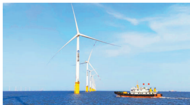
三峡能源“江苏如东海上风电场”项目
