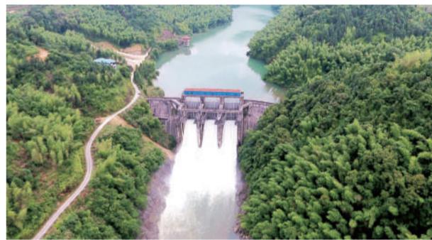
三峡能源“福建大港水电站”项目
