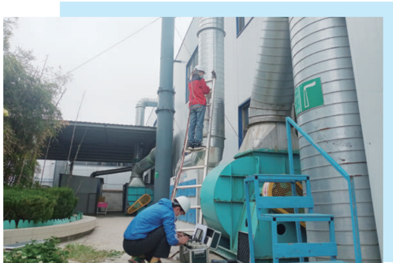
图为济宁市生态环境局汶上县分局对企业VOCs排放达标情况进行现场检查。 王漫雪 董若义 摄
