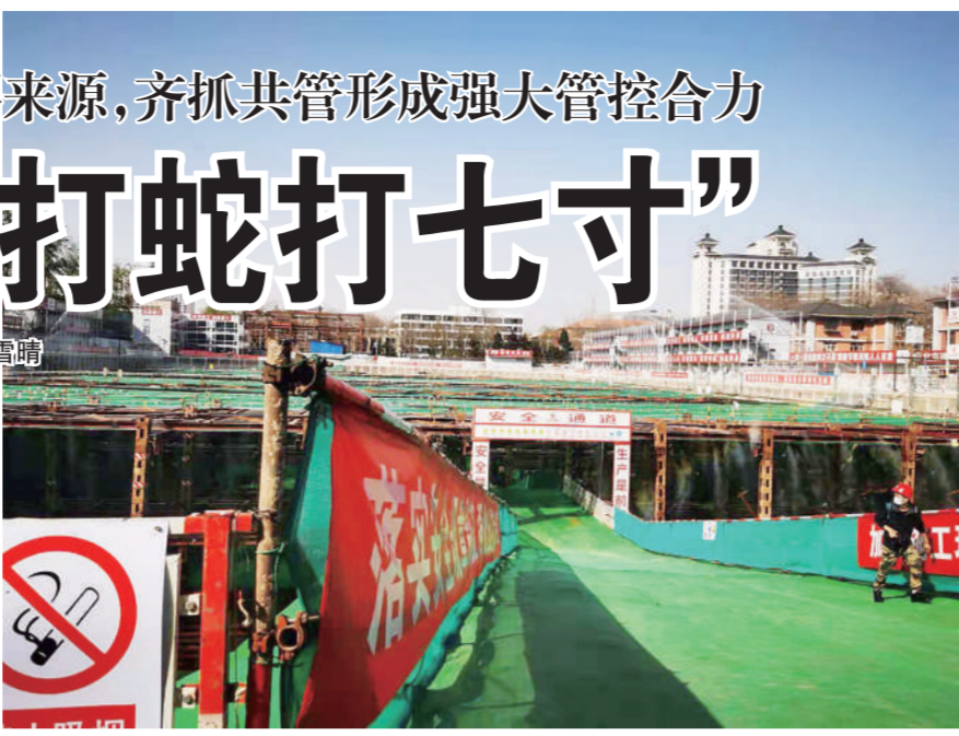
图为北京市防尘天幕下的施工工地。张雪晴摄
