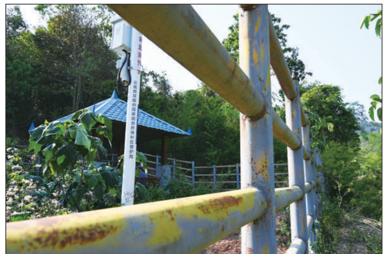
西双版纳积极实施亚洲象栖息地的环境修复工程,力争让亚洲象留在森林内、留在保护区内。同时,在群众居住区域采取了防象栏等工程措施,减少人象冲突事件发生。
