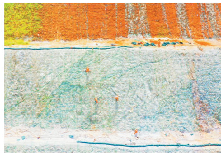
近年来,浙江省台州市路桥区加大城乡生态环境治理力度,大力开展采石场等废弃矿山复垦和生态修复,通过台阶固坡绿化、陡坡植生绿网化等,提高植被覆盖率,美化乡村环境。图为近日在路桥区螺洋街道樟岙村废弃采石场边坡锚固绿化生态修复工地,工人正攀援在岩壁上,进行岩石锚杆加固和铺设勾花钢丝网。
