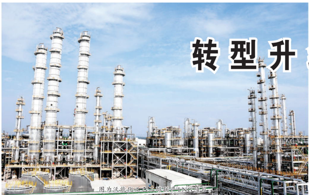
图为沃能化工乙二胺装置LNG项目。
