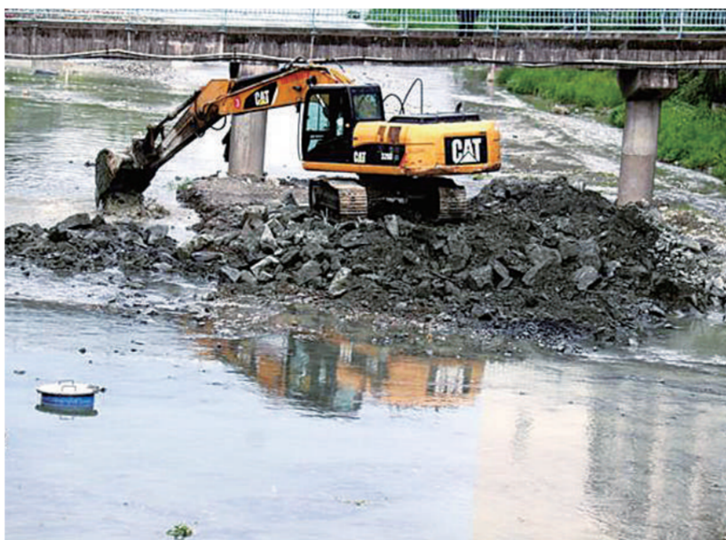
湖北省十堰市马家河水系综合整治项目总投资约2900万元,主要包括污水治理、截污纳管、箱涵疏浚和河道清淤等内容。项目完工后,上中下游管网互联互通,将有效提升高河河流域污水处理能力。图为工人正在河道进行清理作业。薛乐生摄
