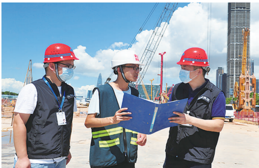
生态环境执法人员在工地现场指导施工单位完善污染防治措施。
