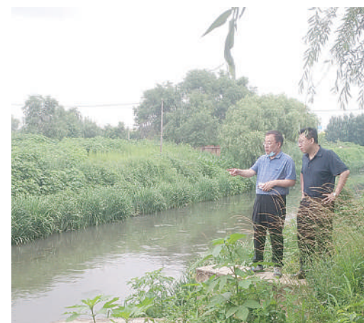
图为赵宏德(左)查看污水排口情况。
