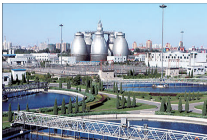
图为北京排水集团小红门再生水厂。资料图片
