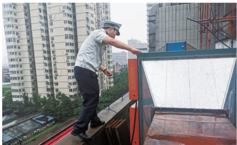
北京市海淀区生态环境综合执法大队日前接居民反映油烟扰民现象后,立即前往现场核实。图为执法人员爬上7层楼顶排查废气排放情况。检查发现,由于近期降雨频繁导致油烟净化设施出现故障。执法人员现场帮助商户完成设施维修,解决了油烟扰民问题。 范李娜摄
