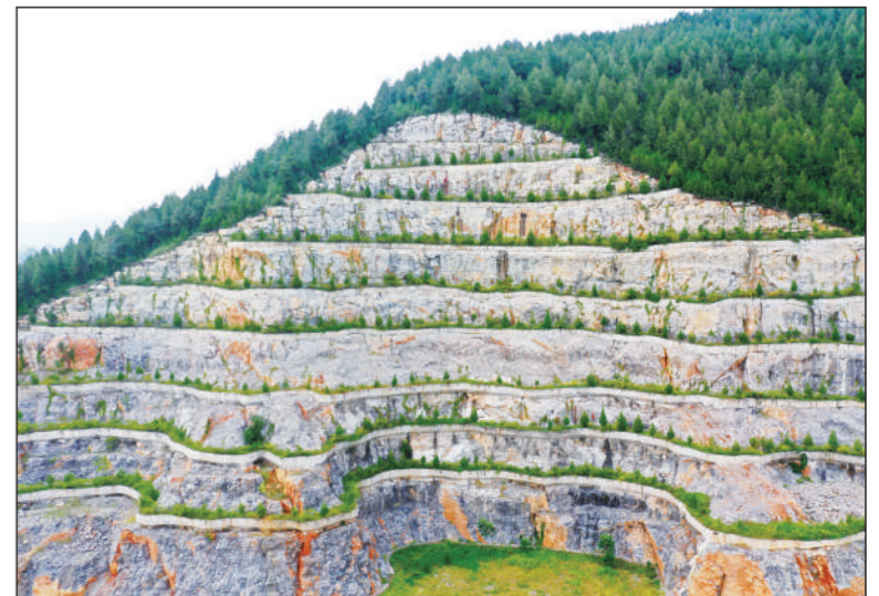
近年来，山东省枣庄市山亭区对多个废弃的采石场山体进行生态修复，通过搭建钢筋混凝土V型槽和填土的方法，在破山体上开辟植树种草的空间，并在其间搭建供水和养料的管道，昔日满目疮痍的矿坑荒山重披“绿装”，正在逐步恢复生机。
