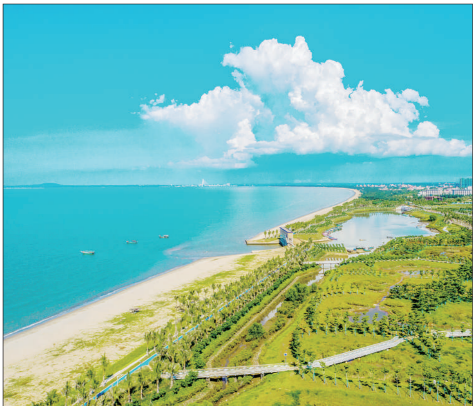
据了解,海南省海口市江东新区防潮堤与海岸带生态修复工程(起步区段)于2019年10月开工建设,全长3.96公里,总面积672.15亩,其中绿地面积542.25亩。目前,该工程已完工并对外开放,成为市民游人休闲观光的好去处。
