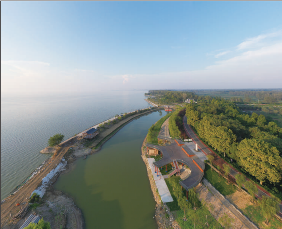
大运河文化带“百里画廊”东起江苏省淮安船闸,西至老子山龟山村,串联大运河、里运河、二河并环洪泽湖,沿水线长约125公里,以沿线生态资源保护及生态修复为目标,构建连续贯通的蓝绿生态网络体系,以充分彰显淮安自然生态之美、水韵人文之美、城乡宜居之美、绿色发展之美。目前,洪泽湖大堤周桥大塘段生态修复工程已进入收尾阶段。 人民图片网供图
