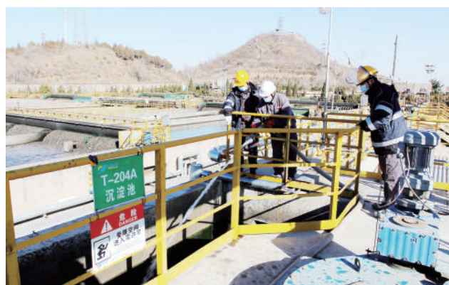
北京燕山威立雅水务有限责任公司牛口峪车间员工在清洗污水提标装置沉淀池。 钱江摄
