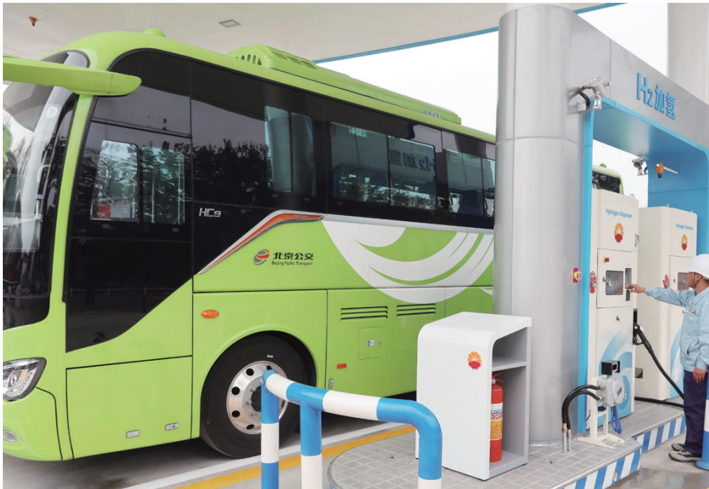
中国石油首座综合能源服务站——北京金龙综合能源服务站日前在北京延庆投运,可提供加油、加气、加氢、充电和便利店“五位一体”服务。冬奥会期间,服务站将为212辆氢燃料电池车提供氢能保供服务。
