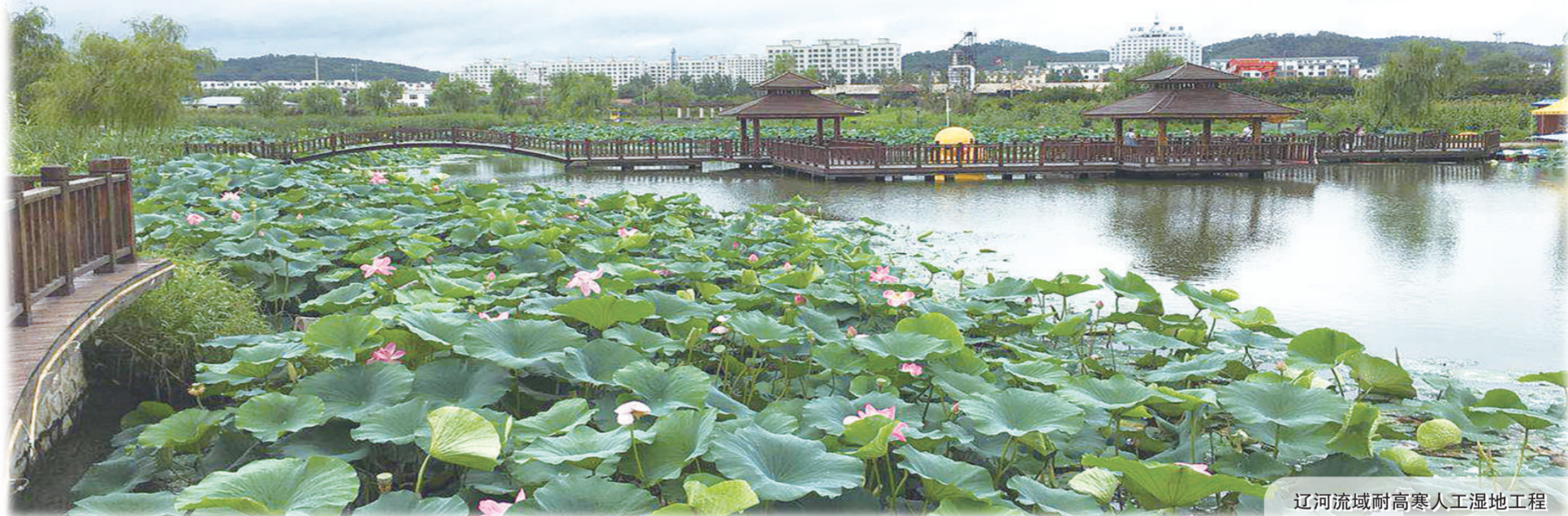
辽河流域耐严寒人工湿地工程
