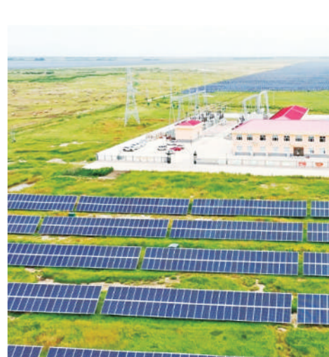
图为建设银行绿色信贷支持的国家电投集团光伏发电项目
