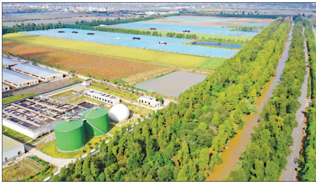
在浙江省温岭市滨海镇,浙江岭农生态农业发展有限公司建成目前台州市最大的沼气发电项目,彻底解决了企业年出栏6万头生猪的排泄物达标处理问题,实现了生态效益和经济效益双丰收。 人民图片网供图
