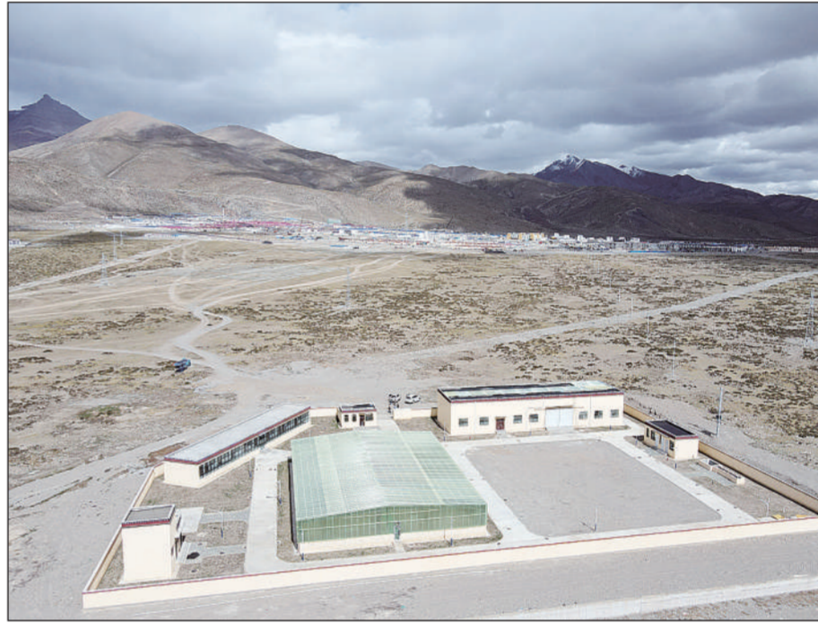
西藏自治区阿里地区普兰县巴嘎乡(塔尔钦)国际旅游小镇是西藏自治区确定的全区首批20个特色小镇示范点之一。图为小镇目前已建成的日处理600立方米的污水处理厂,为生活在这里的群众以及外来游客提供更加良好的环境。
