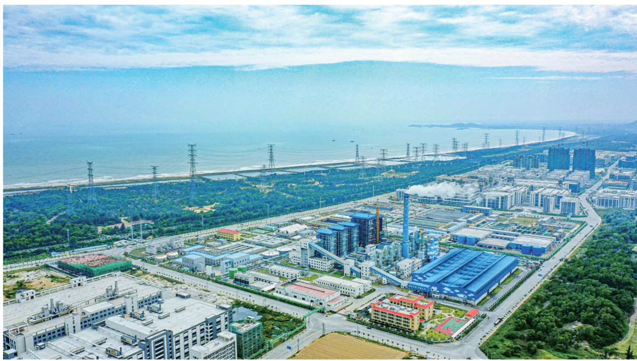
中信环境技术投资建设及运营管理的汕头湖南纺织印染产业循环经济工业园区
