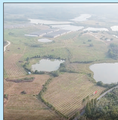
派河中游 王建沟流域综合治理工程、潭冲河小流域城镇水质提升与水环境综合整治工程
