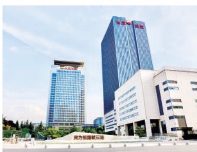
长庆油田固城钻试废液处理站
