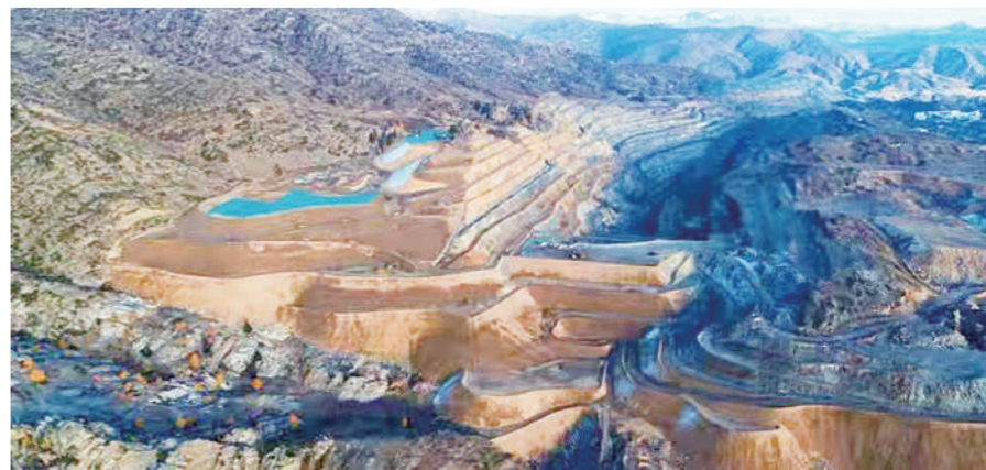
新疆富蕴县蒙库铁矿中段10-22号矿段10采场及周边排土场生态修复工程治理区全景
