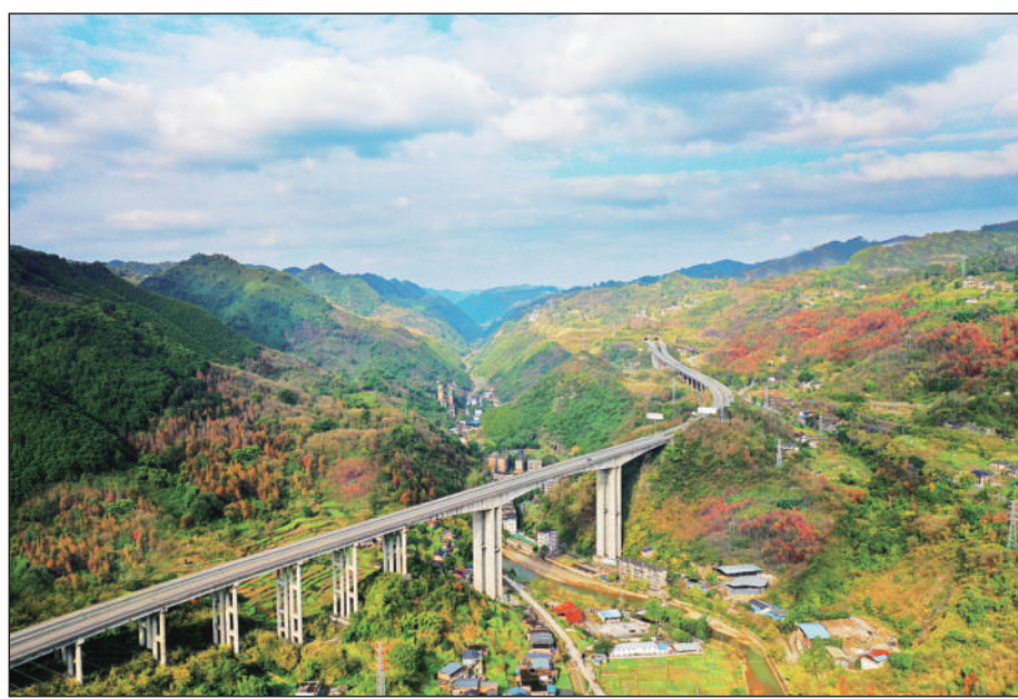
近年来,重庆市万盛经开区加快采煤沉陷区生态环境修复,通过大规模实施绿化工程,将绿色还给矿山,治理成效显著,昔日采煤沉陷区,今日放眼满目绿。 人民图片网供图
