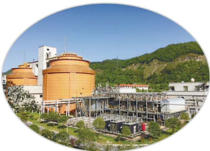
长沙市污水处理厂污泥高级厌氧消化工程
