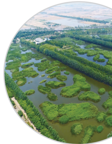
淮安洪泽尾水湿地
