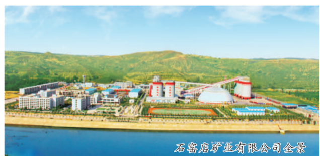
石窑店矿业有限公司全景
