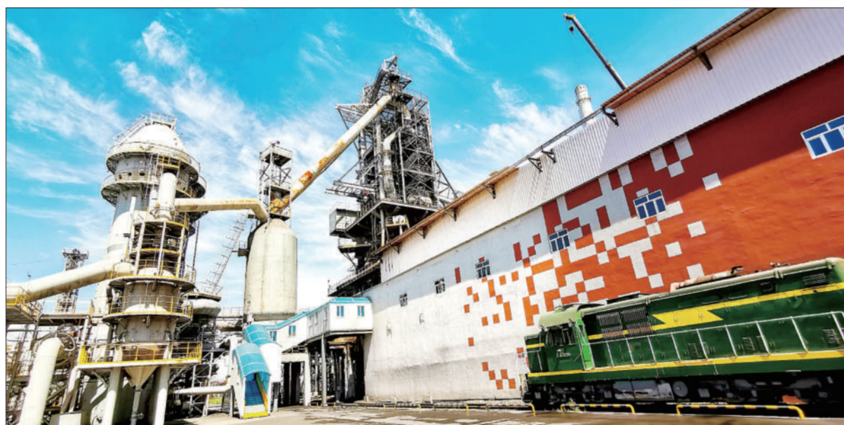
图为中国宝武富氢碳循环高炉,可实现减碳30%以上,引领世界钢铁行业长流程冶炼高炉低碳转型。 资料图片
