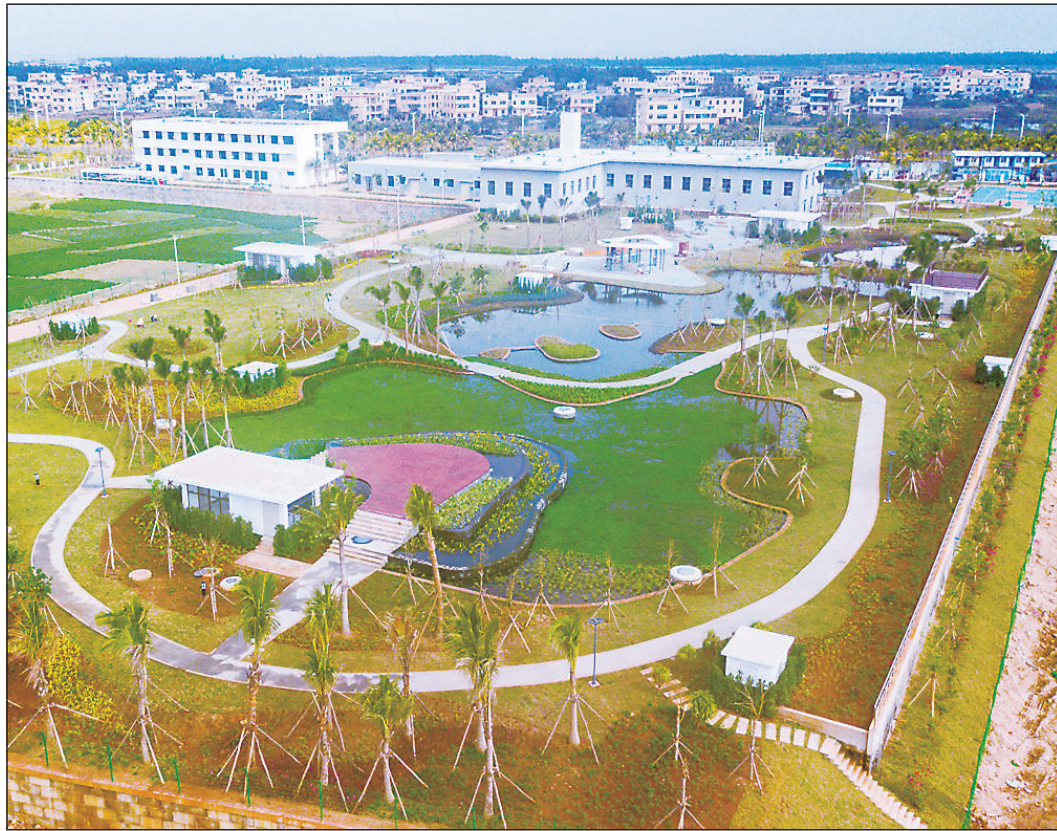
日前,海南省海口市江东新区地理水质净化中心一期工程项目已完成试运营并投入使用。相比传统地上污水处理厂,地理水质净化中心地上是树绿花红水清的湿地公园,地下是高效运转的污水处理厂,有效降低了对居民生活的影响。
